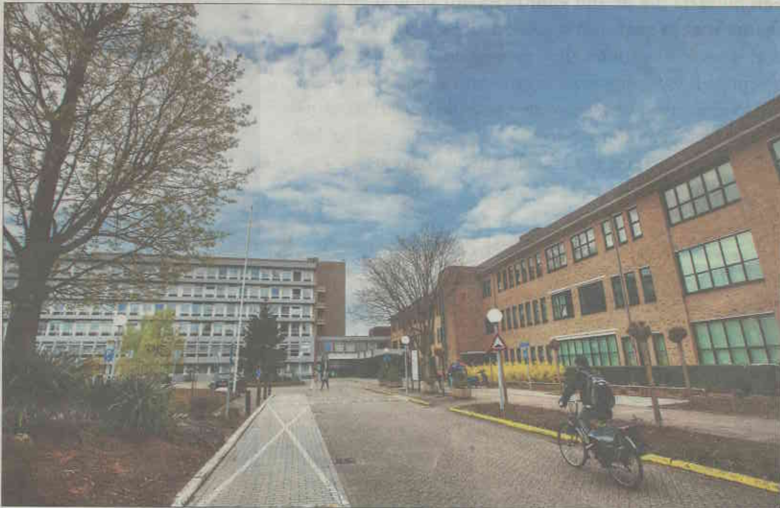
Deel van het Annadalterrein, achter de rechtbank. De nieuwe eigenaren willen er 650 studenten huisvesten.
